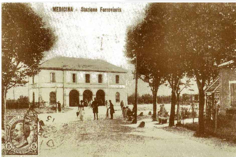
Via Saffi con stazione ferroviaria. (Collezione T. Trebbi).
